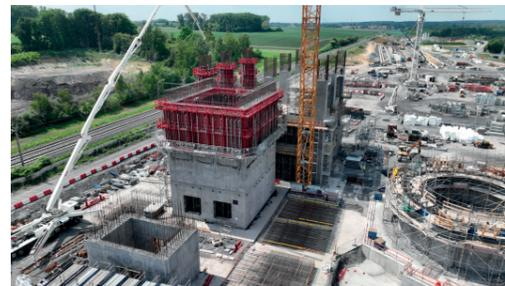
La construction du **premier support** progresse conformément au planning: **deux niveaux sur trois sont finalisés**. Le ferrailage et le coffrage du troisième niveau sont en cours.
